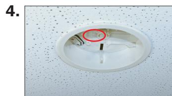
Akku anschließen (nur bei Einzelbatterieleuchten). Deckel auf das montierte Leuchtenghäuse drücken.
