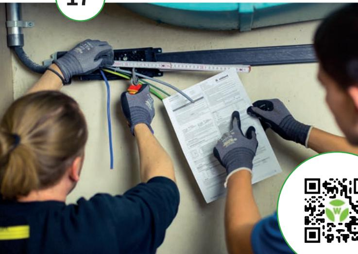
Die Zuleitung wird in das Anschlussmodul mit M32-Kabelverschraubung eingespeist.
