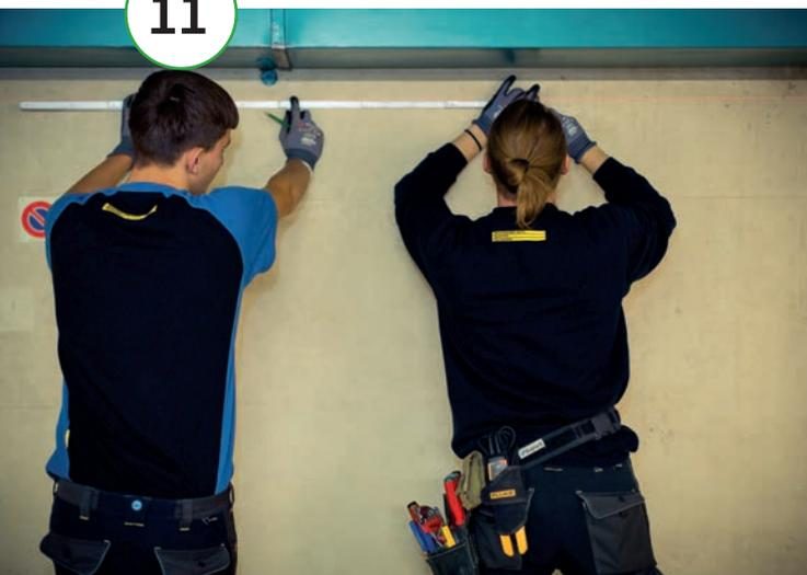
Legen Sie nun die Abstände der Befestigungsbügel fest und zeichnen Sie die Position über die ganze Länge an.
