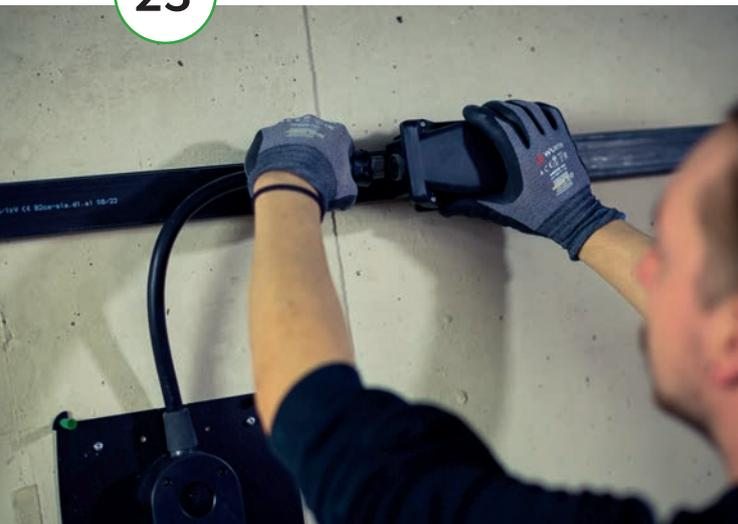
Das andere Ende der Abgangsleitung kann nun an der Ladestation (bzw. der Sicherungsbox) angeschlossen werden.
