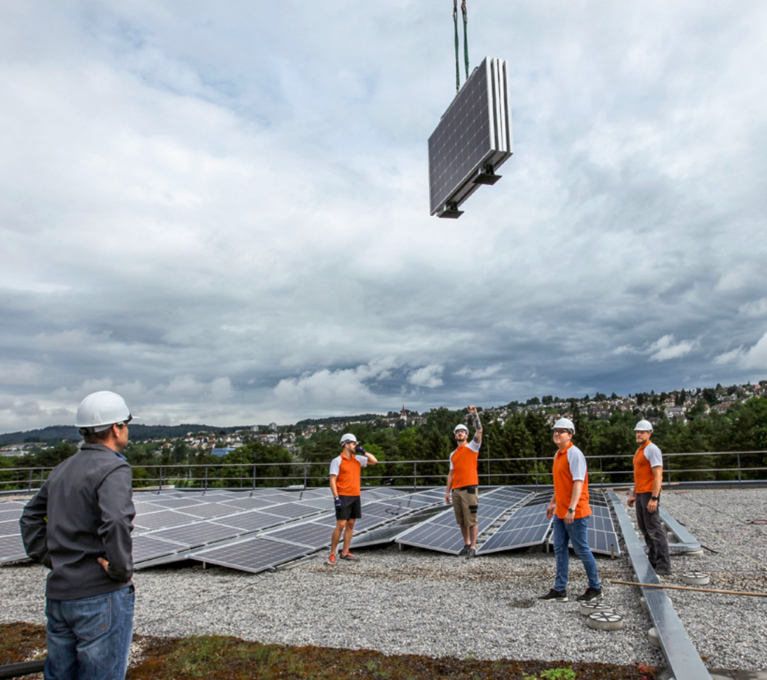
Die vormontierten Module werden per Kran aufs Dach gehoben.
