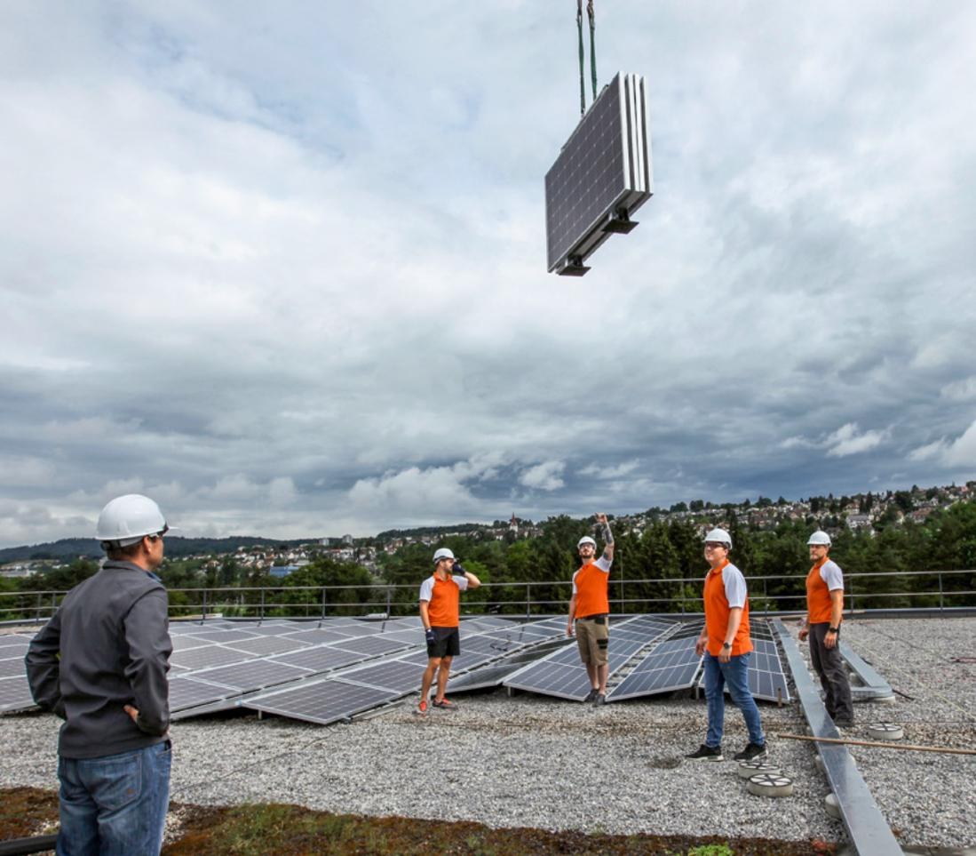
Les modules prémontés sont levés sur le toit à l'aide d'une grue.
