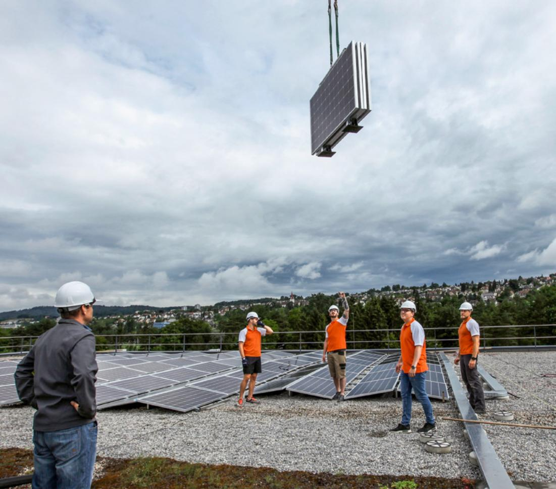
I moduli premontati vengono sollevati con l'ausilio di una gru.
