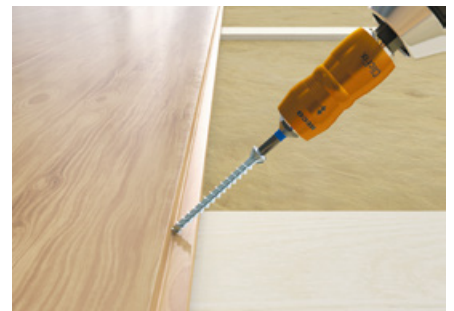
Fixierung von Dielenbelag
