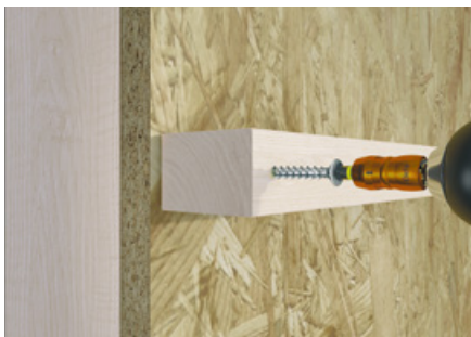
Befestigung einer Installationsebene
