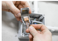
Verdrahtete Klemme in die Gelbox einlegen.
